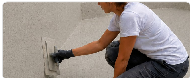
Étanchéité de piscine
