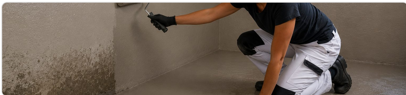
Traitement contre l'humidité d'un mur et d'une dalle de sous-sol avec IMPERFLEX FIBER-1C
