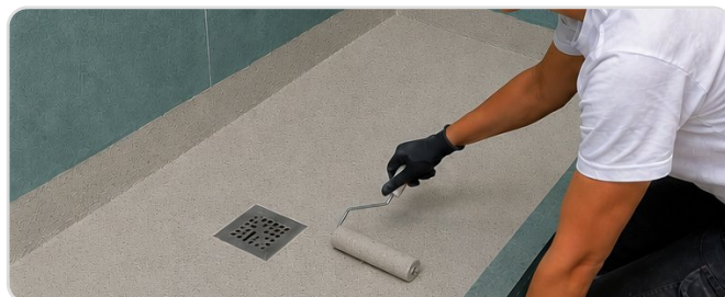
Impermeabilização de base de duche
