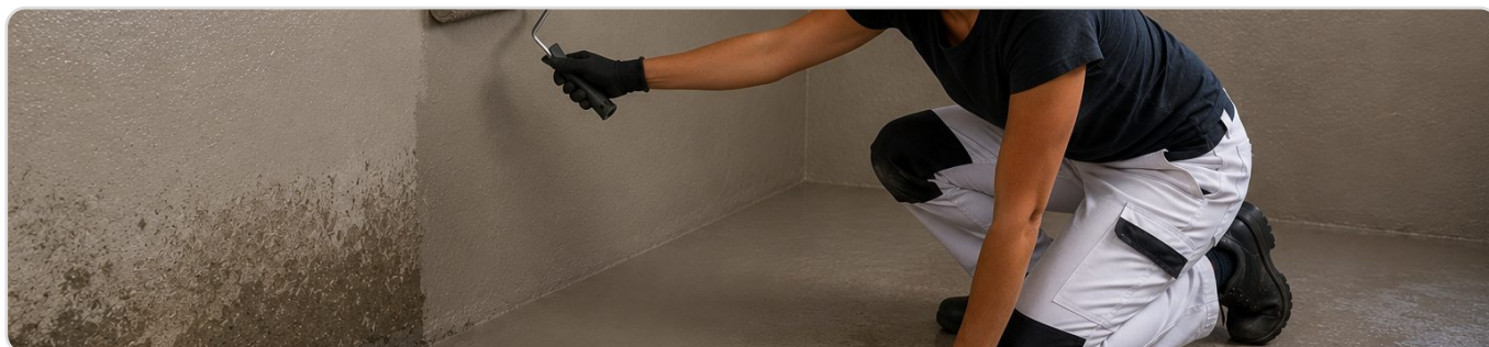
Tratamento de humidade em parede e laje de cave com IMPERFLEX FIBER-1C
