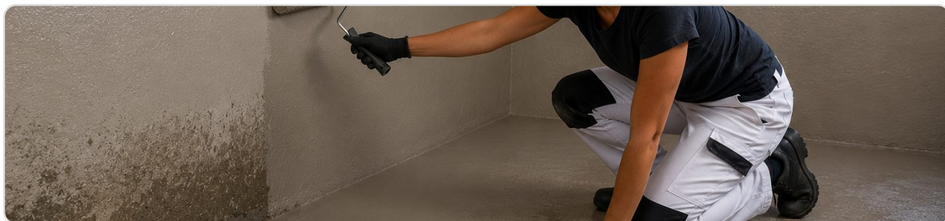
Trattamento antiumidità di muro e platea di scantinato con IMPERFLEX FIBER-1C
