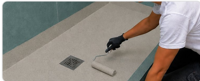
Impermeabilizzazione di piatto doccia
