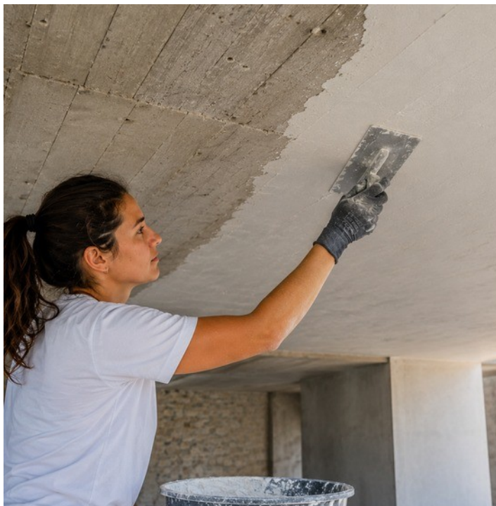
Alisamento de uma superfície de betão em teto
