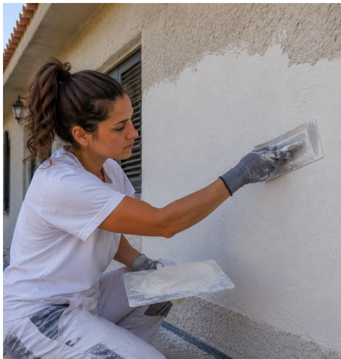
Regularização de fachada com TECNOCEM COSMETIC
