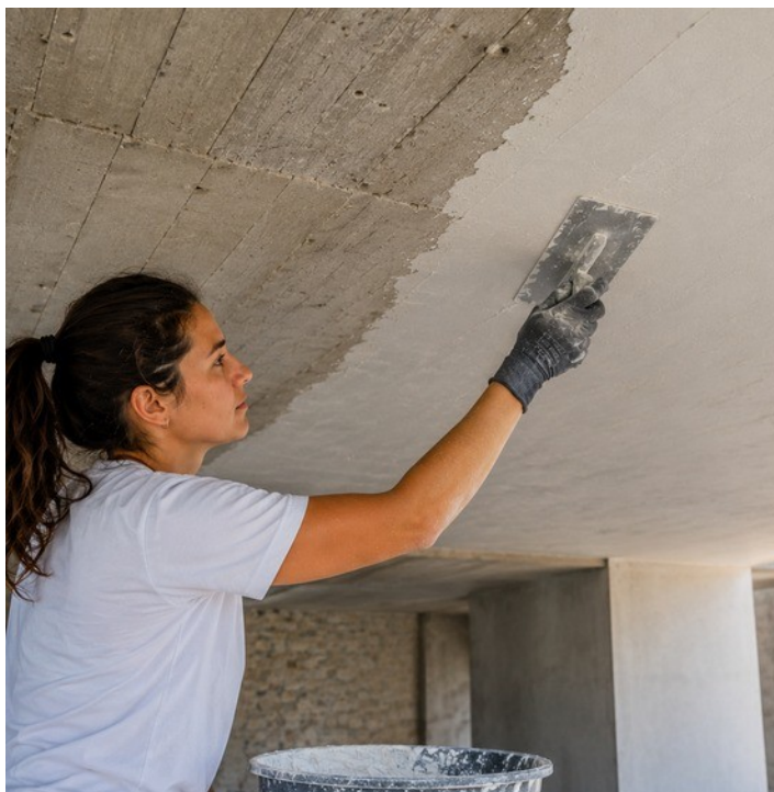
Lisciatura di una superficie in calcestruzzo a soffitto
