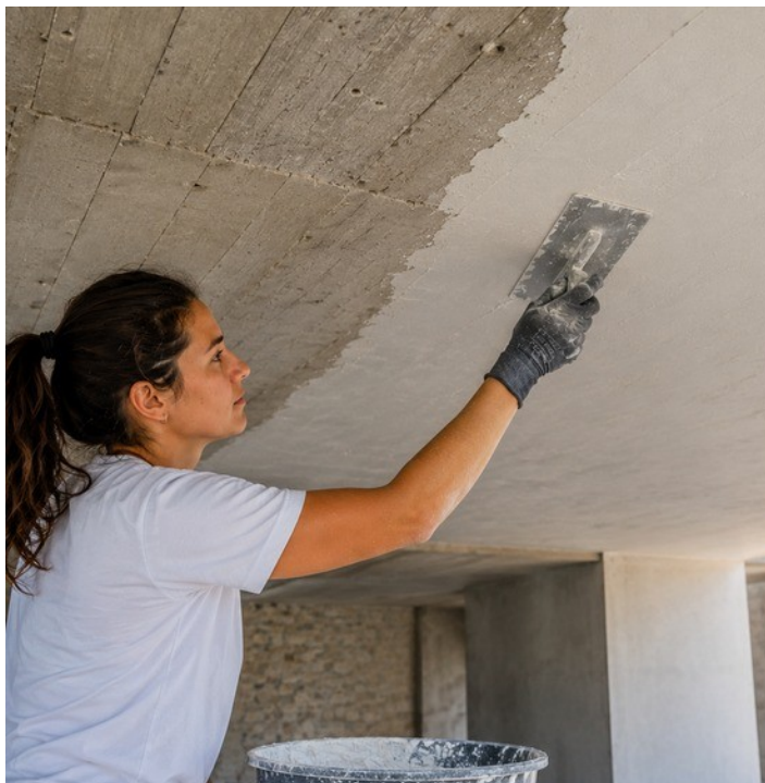
Lissage d'une surface en béton en plafond
