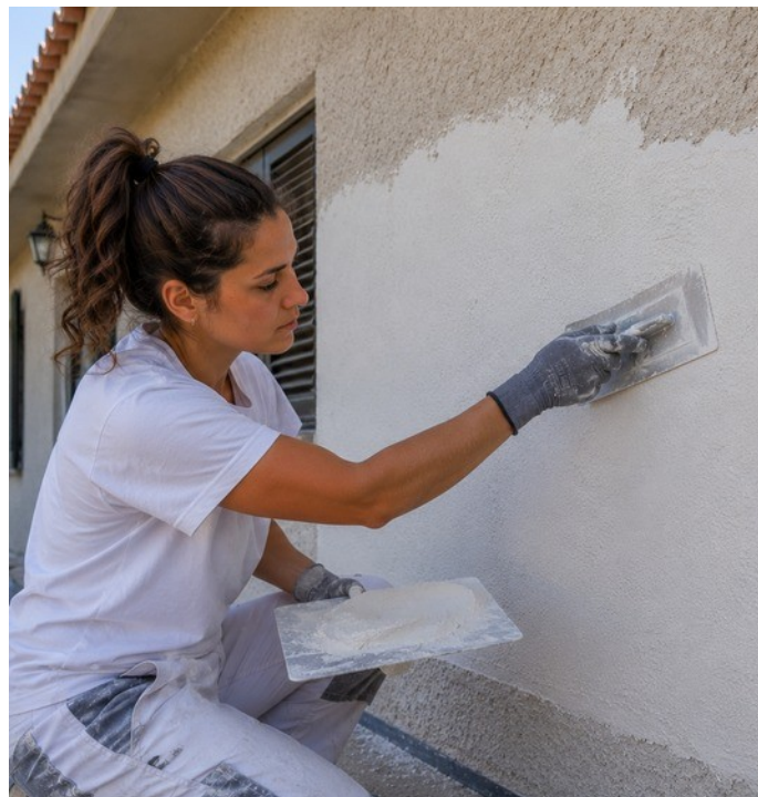
Régularisation de façade avec TECNOCEM COSMETIC
