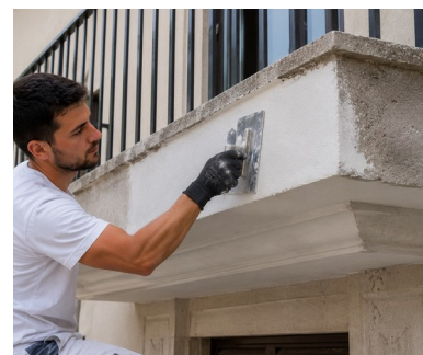
Réparation et lissage d'une rive de balcon avec TECNOCEM COSMETIC
