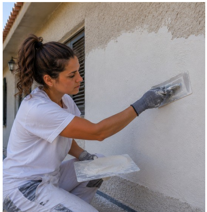
Regularización de fachada con TECNOCEM COSMETIC
