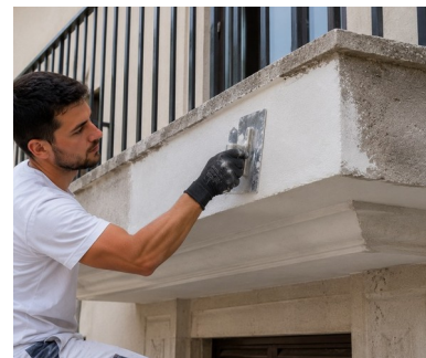
Reparación y alisado de canto de balcón con TECNOCEM COSMETIC
