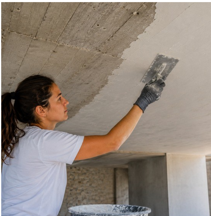
Alisado de superficie de hormigón en techo
