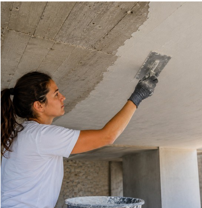
Glättung einer Betonoberfläche an der Decke
