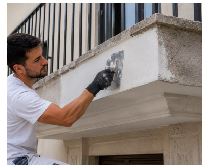
Reparatur und Glättung einer Balkonkante mit TECNOCEM COSMETIC
