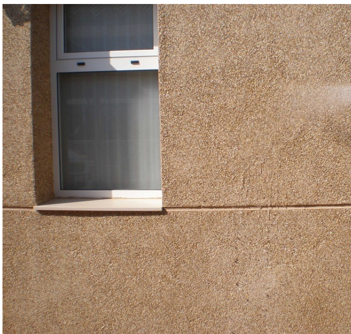
Hidro A appliqué sur une façade en enduit monocouche
