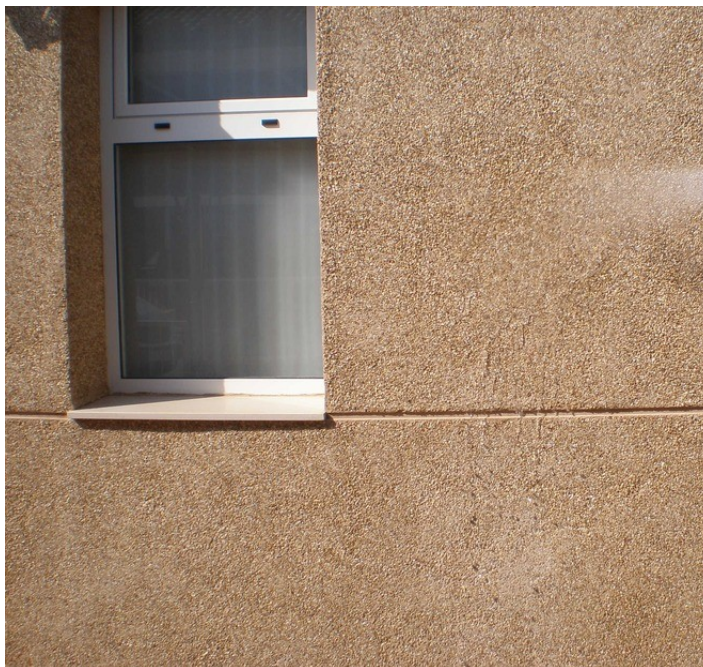
Hidro A aplicado sobre fachada de reboco monocamada
