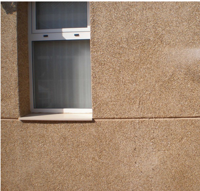
Hidro-A aufgetragen auf eine Fassade aus einschichtigem Putz
